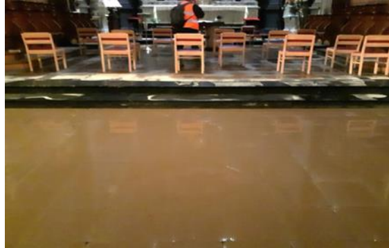
Sur la photo ci-dessus, on voit que le niveau de l'eau était déjà fort descendu
